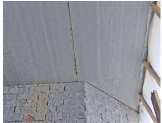
Detaliu la exterior a intrării principale Poiana Brașov, proprietate privată Proiectant: Arh. C.M. Maximilian Zielinski Anteprenor: Prens
