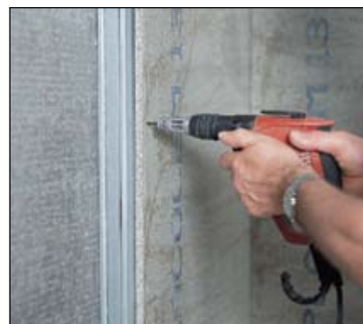
Prinderea pe structură metalică
