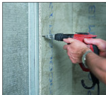
Prinderea pe structură metalică
